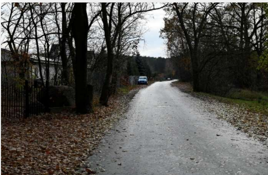
Silno ul. Sosnowa
