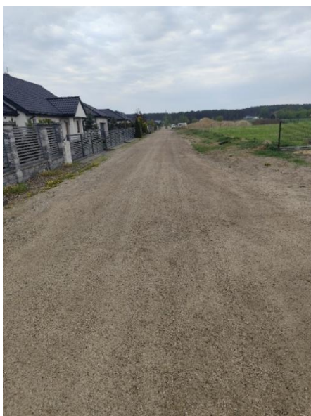
Silno, ul. Brzozowa- wykonanie podbudowy drogi
