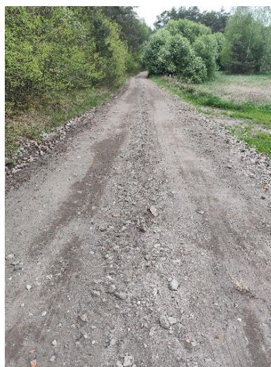
Silno, ul. Łąkowa - wykonanie podbudowy drogi
