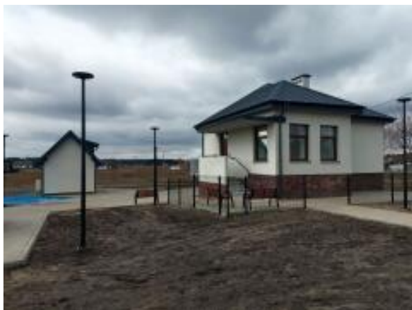
Budynek dawnego dworca kolejowego w Obrowie przy ul. Dworcowej. Stan po remoncie generalnym.
